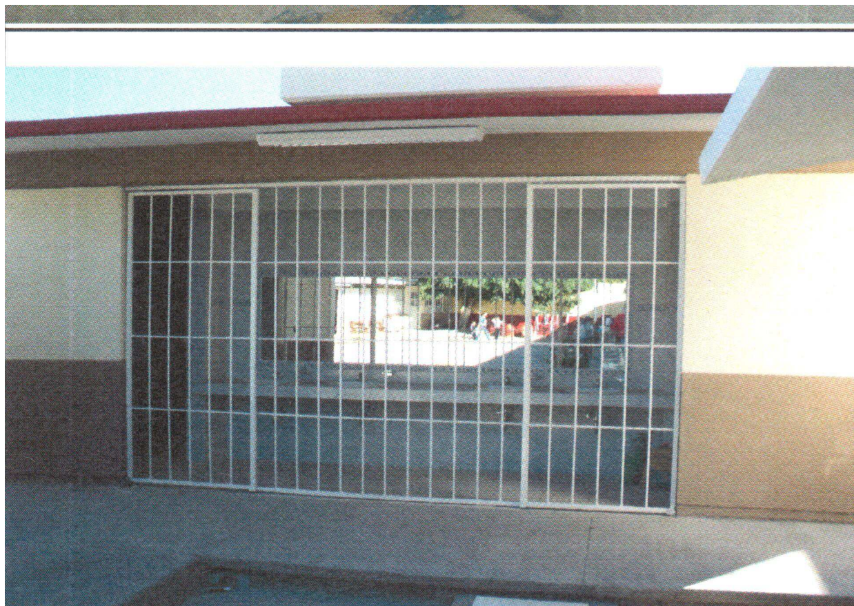
PRIMARIA PROFR. JOSE CIRIACO CRUZ COLONIA SANTA FE SAN LUIS POTOSI, S.L.P.
